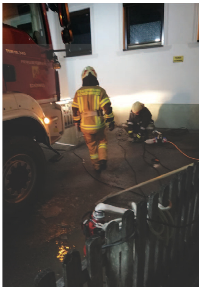
Keller auspumpen nach Rohrbruch.
